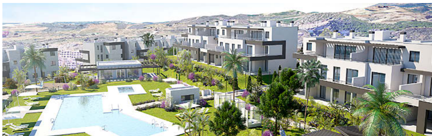
Residencial Nereidas de Metrovacesa (izqda.). Artola Homes de Neinor en Málaga (dcha.) y Habitat Valle Romano en Estepona. eE:
